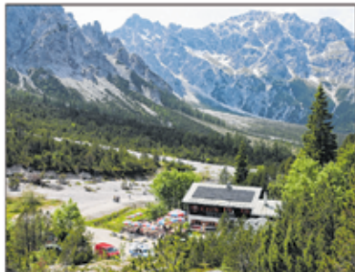
Die Wimbachgrieshütte liegt fast am Endes des Wimbachtals auf 1327 Metern Höhe.
